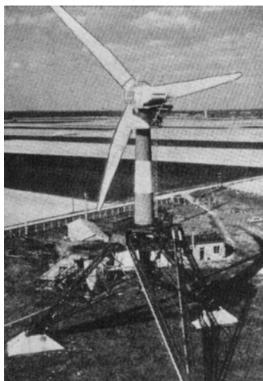
شکل ۴- توربین بادی مولد برق که نزدیک پاریس نصب شده است ( به قدرت 800KW در بادی به سرعت اسمی ۵۹ کیلومتر در ساعت ) [ ۶ ]
