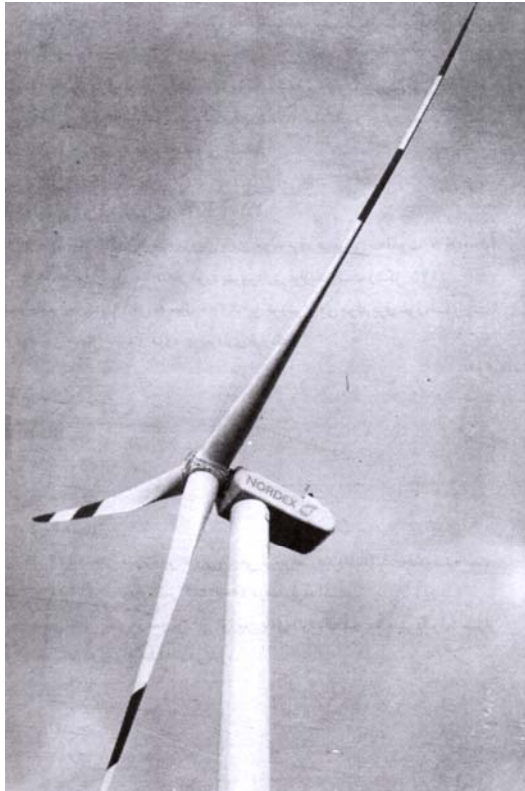
شکل -۴۴ توربین بادی شرکت نوردکس به ارتفاع ۱۲۰ متر و قدرت ۲۵۰۰ KW [ ۶ ]
